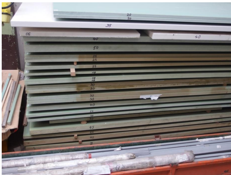
Obr. 2.7.1.2 -2 Uskladnění materiálu volně na zemi bez rozřídění
