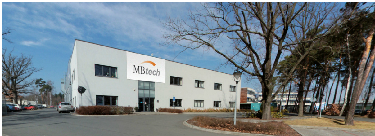
obr. 1: sídlo a prototypová laboratoř společnosti MBtech Bohemia v Daimlerově ulici v Plzni
