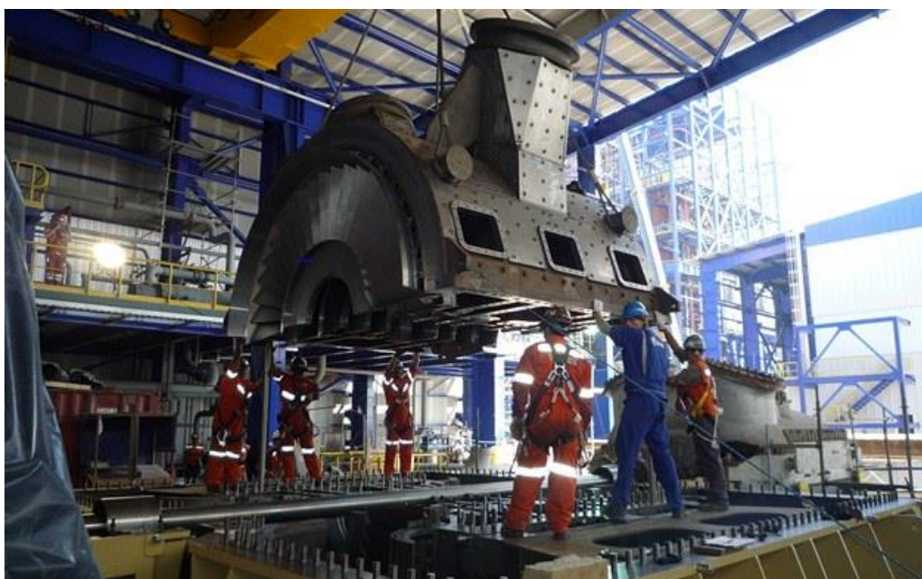
Obrázek č. 3 – Montáž parní turbíny Škoda 165 MW v chilské elektrárně Mejillónes [12]
