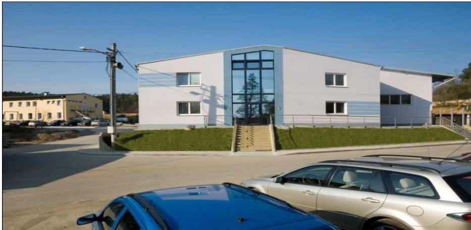
Obr. 1.1: GTW BEARINGS s.r.o. - pohled na hlavní budovu [4]
