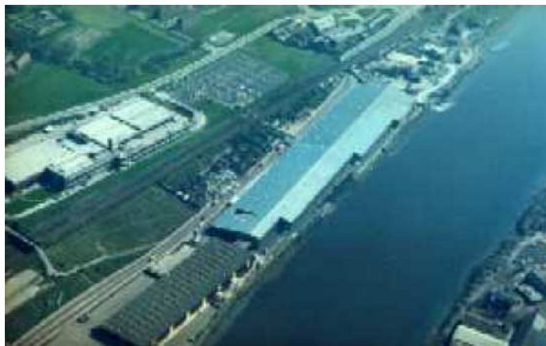
Obr. 3.1: Pohled na výrobní halu firmy Michell Bearings Ltd. [8]
