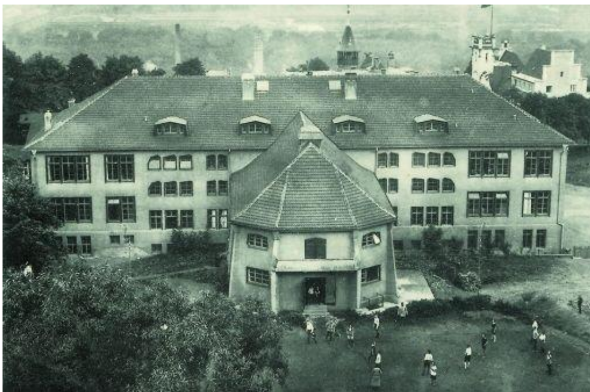
Obr. 3 - První Svobodná Waldorfská škola ve Stuttgartu
