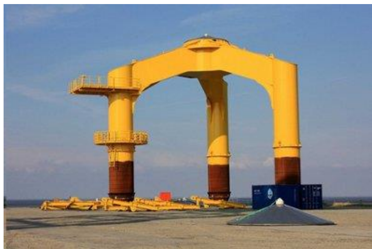
Obrázek 3.6: Konstrukce tri-pile [31]
