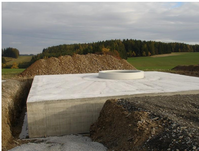
Obrázek 2.2: Pohled na hotový betonový základ VTE [9]
