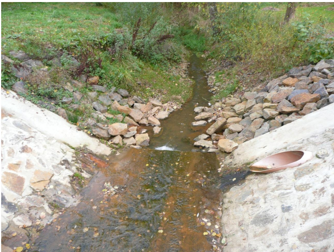
Obr. 1 Odtok z návesní nádrže v Dolních Sekyřanech
