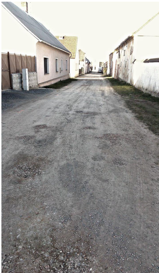
Obr. č. 10: Původní stav ulice Příčná v obci Chotěšov
