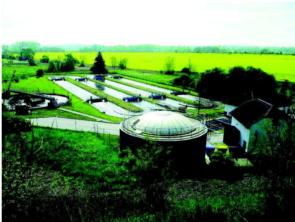
Obrázek č. 28 – ČOV Hostivice před rekonstrukcí
