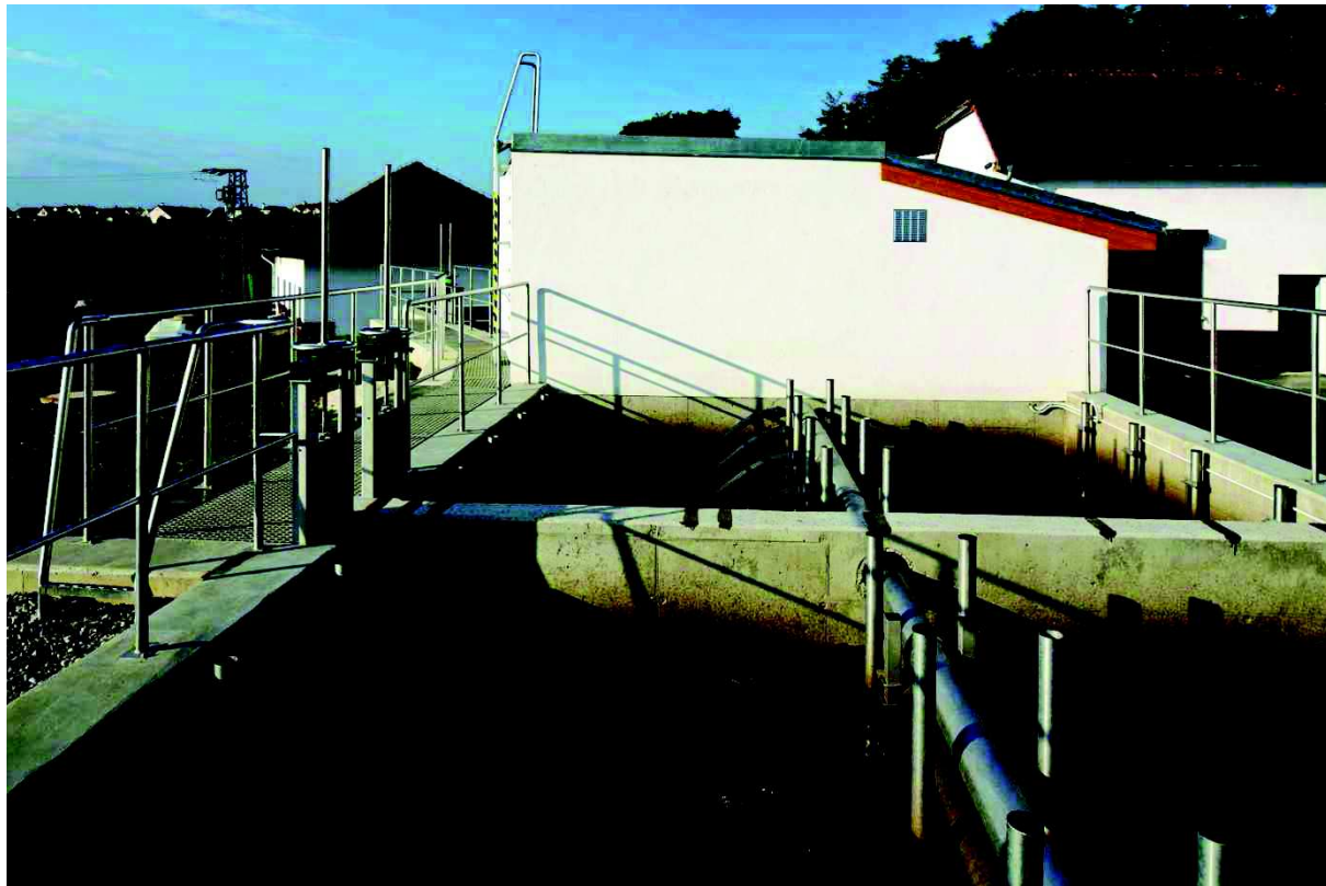
Obrázek č. 30 – Objekt MBR I. a II. sekce
