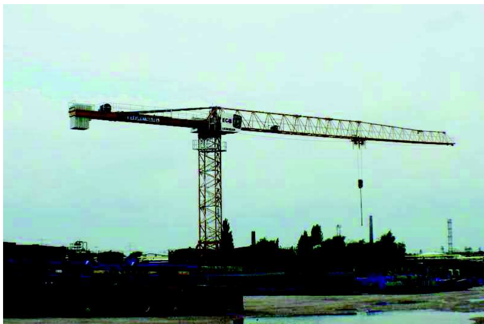
Obrázek č. 7 – Věžový jeřáb LIEBHERR 110 EC - B
