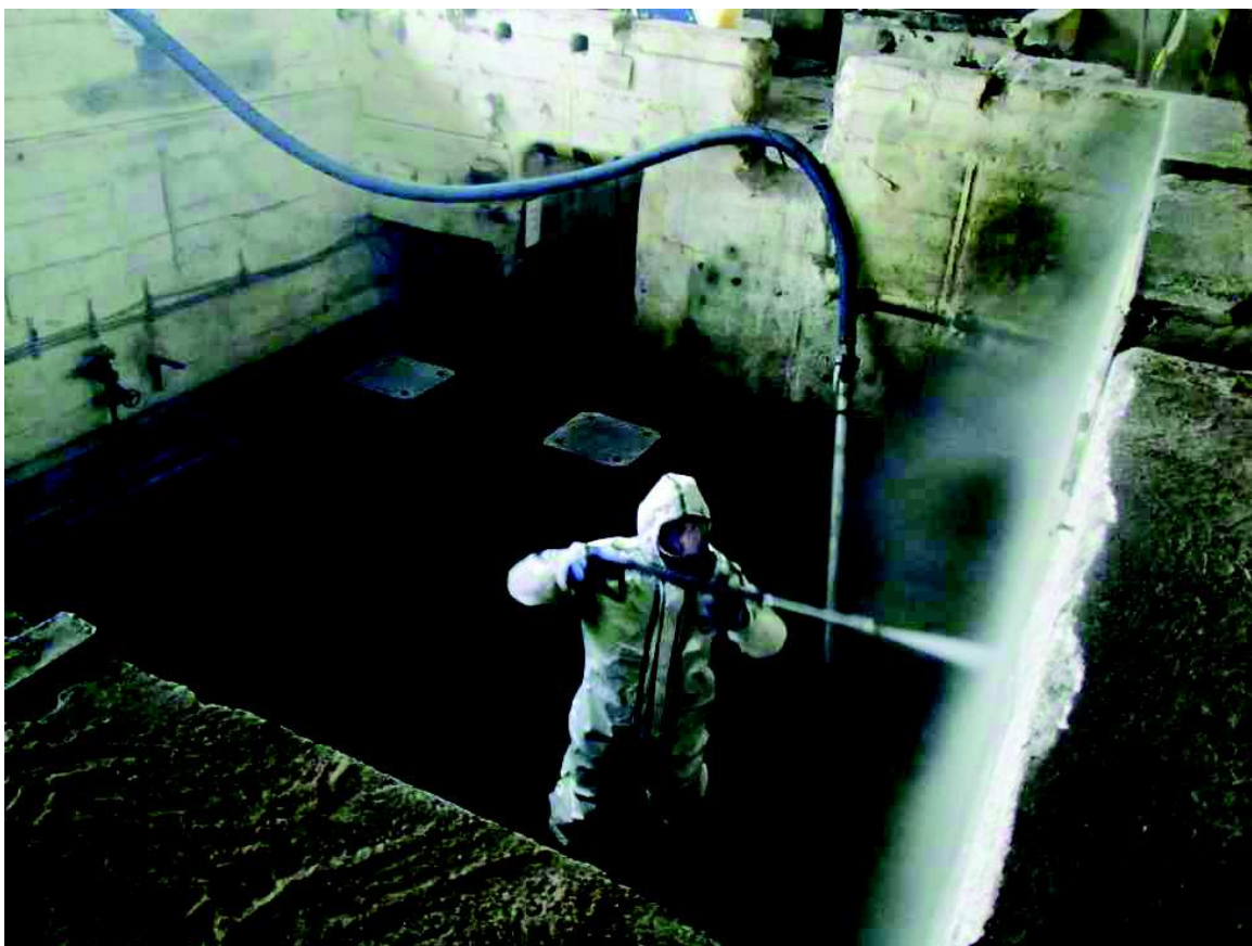
Obrázek č. 35 – Otryskání povrchu betonových konstrukcí
