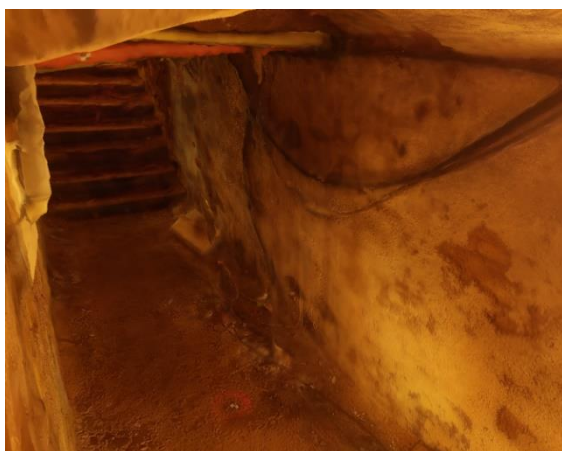
Obrázek 61: Snímek modelu (absence dřevěných podpěr)
