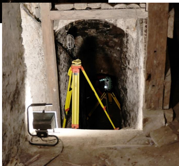
Obrázek 10: Pohled na schody do druhého podzemního podlaží
