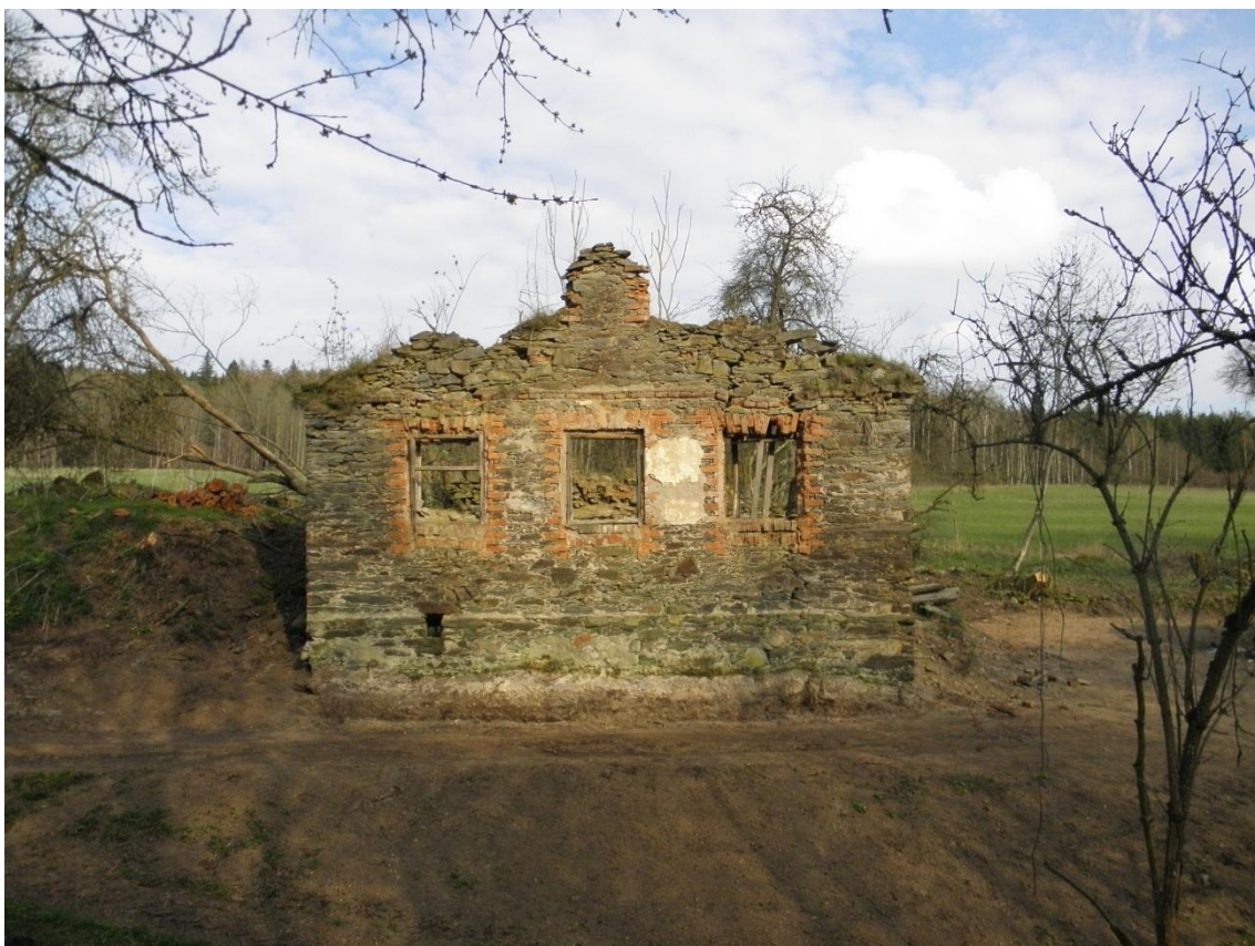
Obrázek 16: Objekt číslo 22, štítová zeď.
