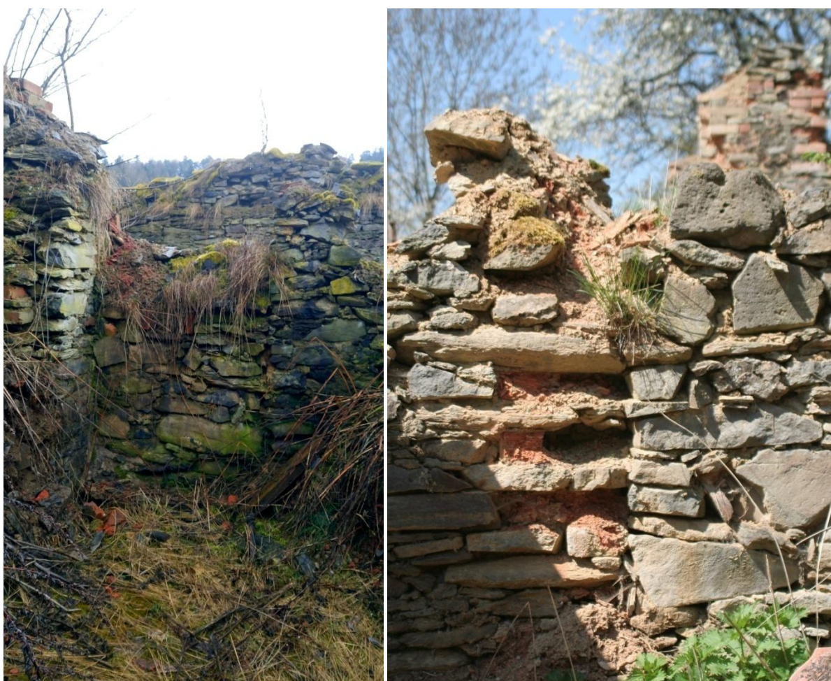
Obrázek 15: Zazděný vstup - pohled ze síně (vlevo), pohled z komory - detail (vpravo).
