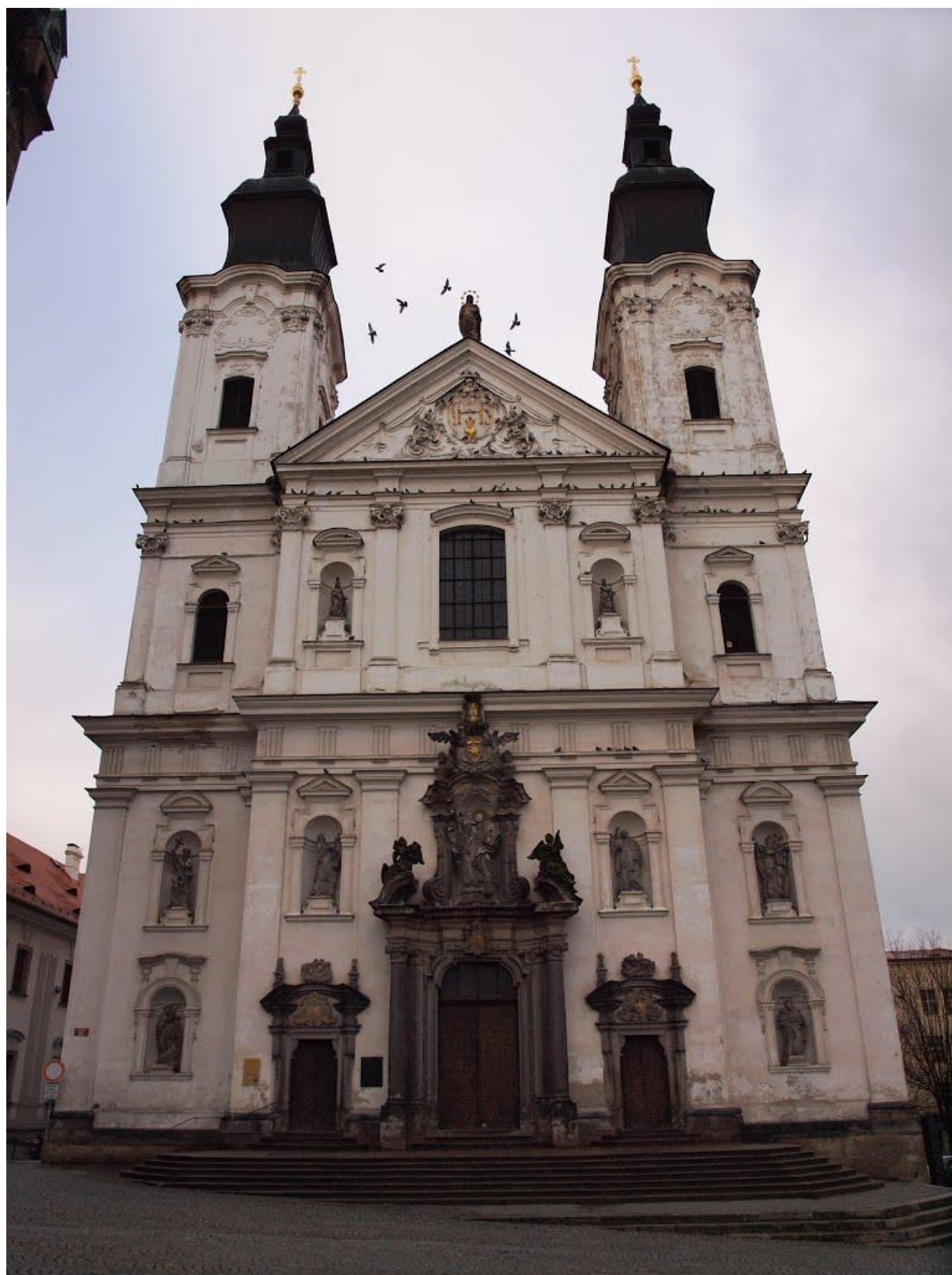
Příloha č. 9 – Průčelí kostela Neposkvrněného početí Panny Marie a sv. Ignáce z Loyoly. 172
