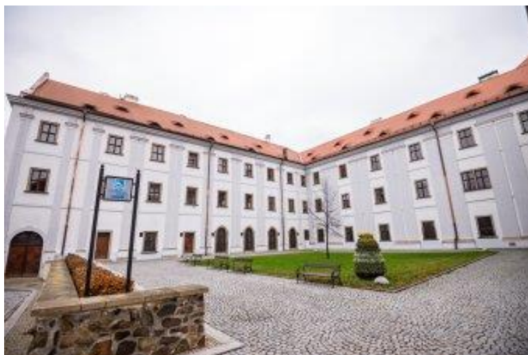
Příloha č. 6 – Dnešní podoba bývalé jezuitské koleje v Klatovech, jihovýchodní křídlo. 169
