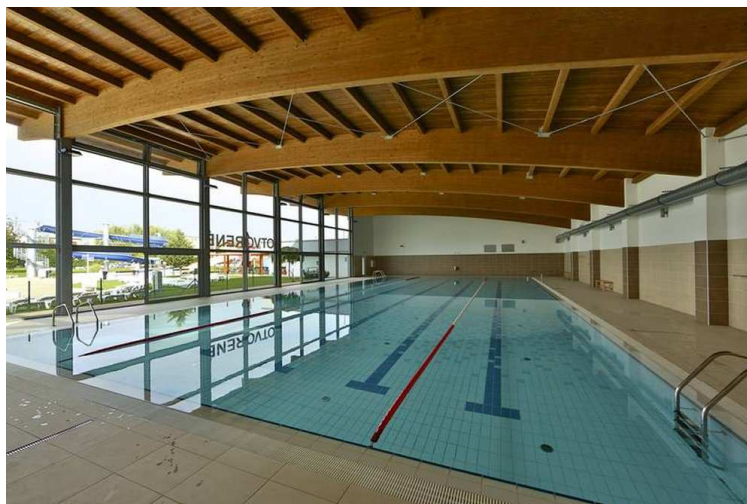
Obrázek 29 Přestřešení bazénové haly dřevěnými lepenými vazníky (Zdroj: http://m.taros-nova.cz/files/gallery/stavby/Zastreseni_bazenu-Swim_arena_Senec/swimarenasenec.jpg )
