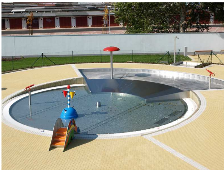
Obrázek 7 Rekreační bazén - brouzdaliště
