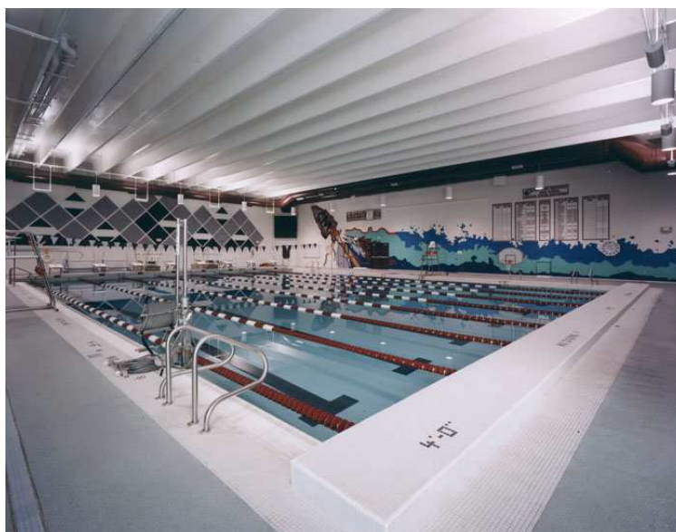
Obrázek 31 Přestřešení bazénové haly železobetonovými vazníky
