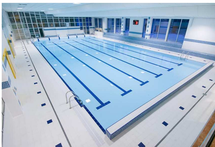
Obrázek 32 Železobetonová bazénová vana
