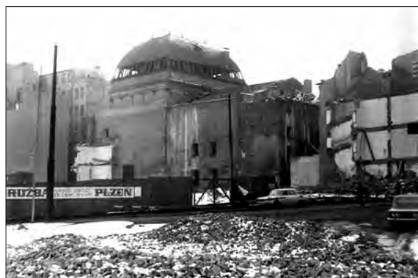
Demolice Malého divadla, 1977. Zdroj: Archiv města Plzně. Die Sanierung des Kleines Theaters, 1977. Quelle: Der Stadtarchiv Pilsen.
