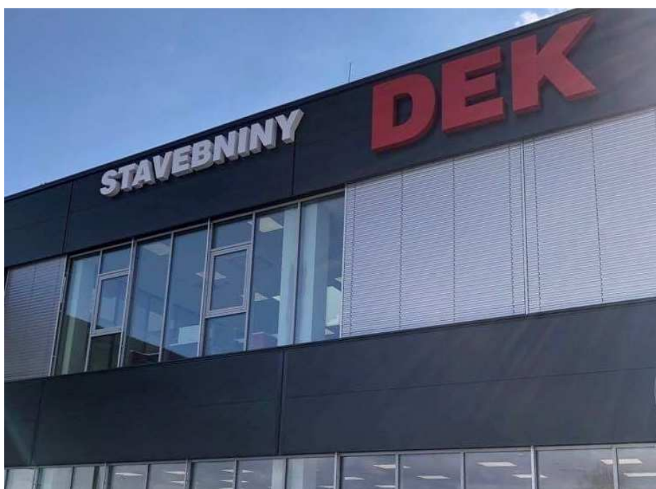
Obr. č. 16 Pohled na halu po instalaci žaluzií
