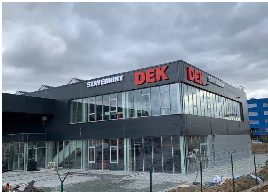
Obr. č. 15 Pohled na halu před instalací žaluzií
