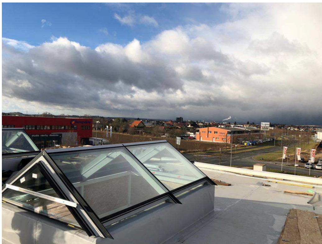
Obr. č. 13 Pohled na světlíky před instalací stínění Airomatic od společnosti Stobag
