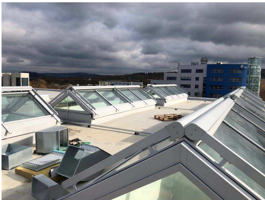
Obr. č. 14 Pohled na světlíky po instalaci stínění Airomatic od společnosti Stobag
