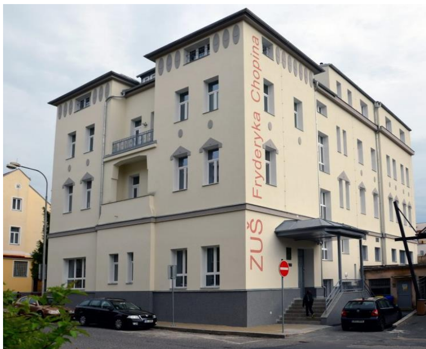
Obrázek č. 8 – Nová budova Základní umělecké školy Fryderyka Chopina, zdroj: http://www.stavbykarlovarska.cz/cz/hlasovani/zus-fryderika-chopina-173
