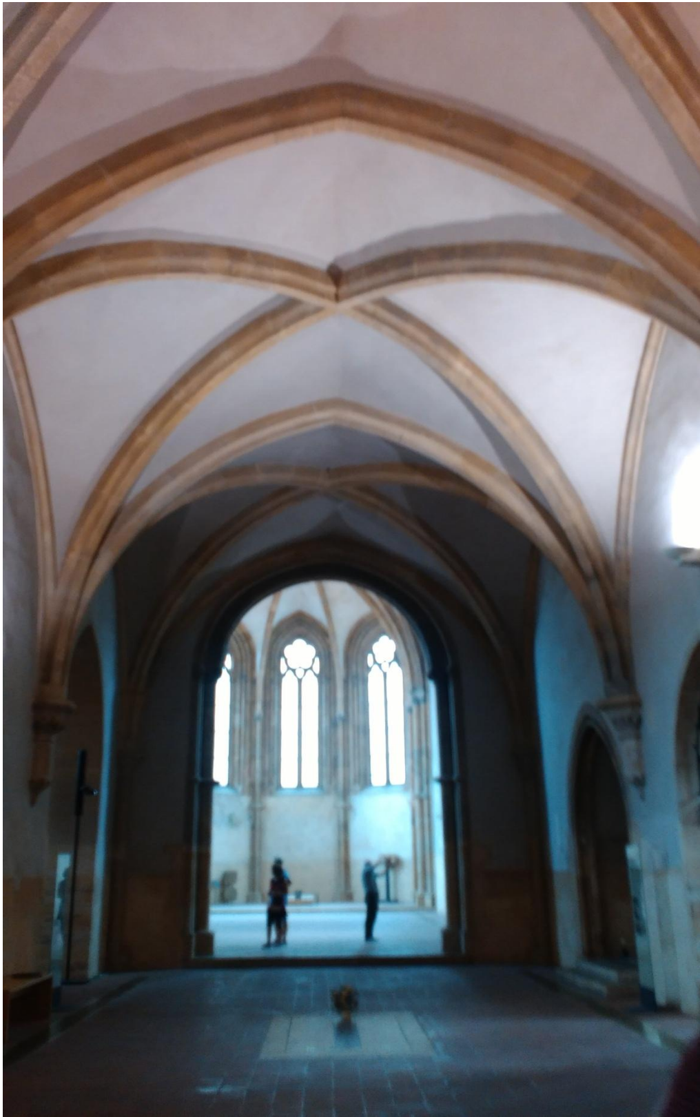
Obrázek 7: Kaple Panny Marie a průhled do svatyně Salvátora
