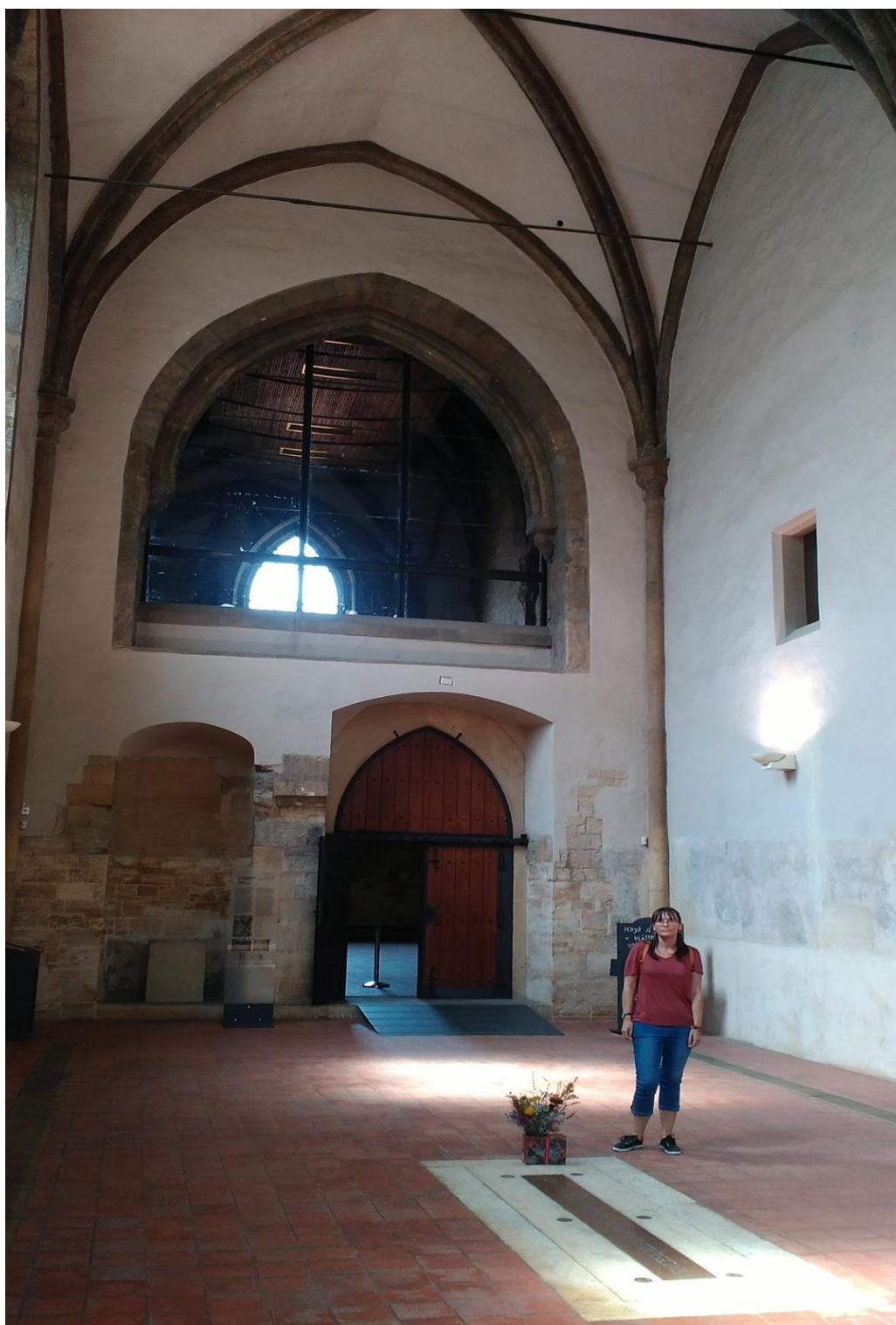
Obrázek 12: Presbytář kostela sv. Františka s průchodem do kostela
