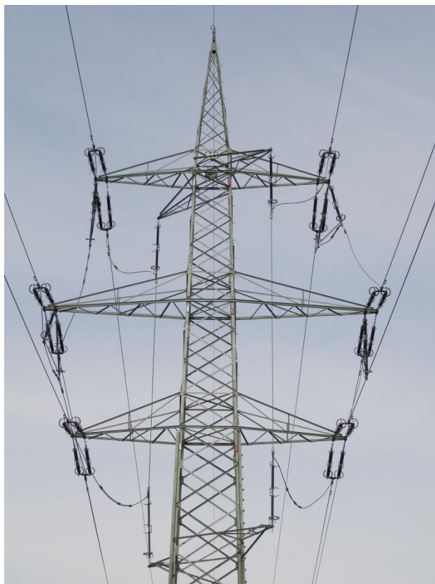
Obr. A.16: Zákrtový stožár typu Soudek [2]
