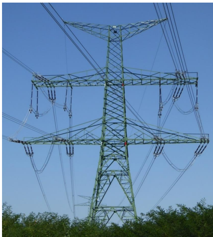
Obr. 30: Zákrutový stožár typu Dunaj s úplným zákrutem na obou potazích [2]
