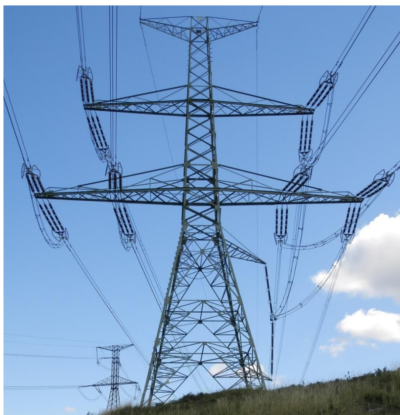
Obr. A.3: Zákrutový stožár typu Dunaj 3 [2]
