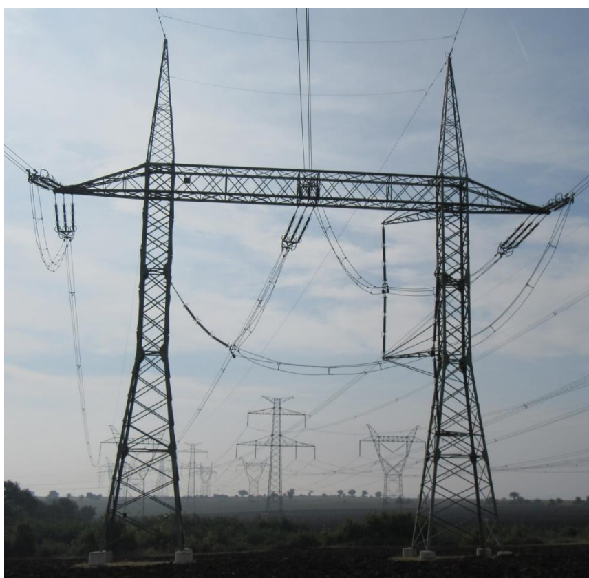
Obr. A.9: Zákrutový stožár typu Portál 4 [2]
