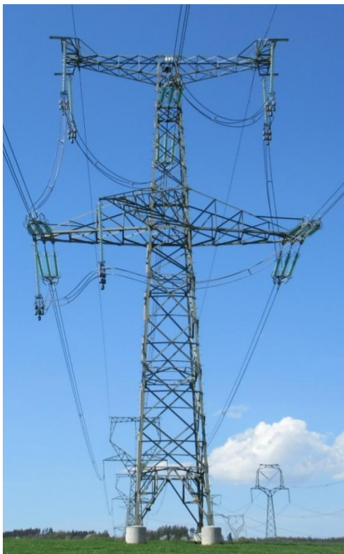
Obr. A.11: Zákrutový stožár typu Delta 2 [2]
