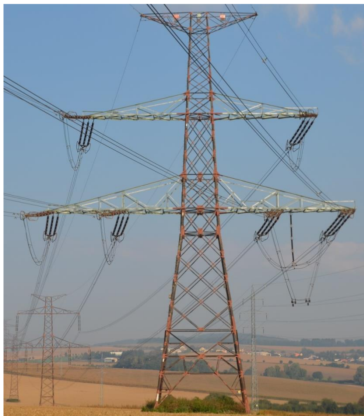
Obr. A.2: Zákrutový stožár typu Dunaj 2 [2]
