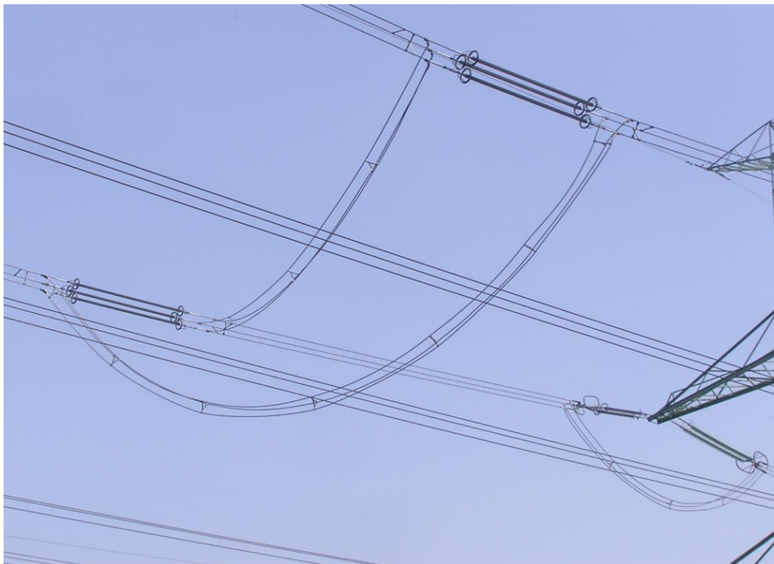
Obr. A.15: Transpozice v rozpětí mezi stožáry 2 [2]
