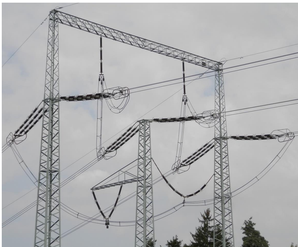
Obr. A.13: Zákrutový stožár typu Třídřík 2 [2]
