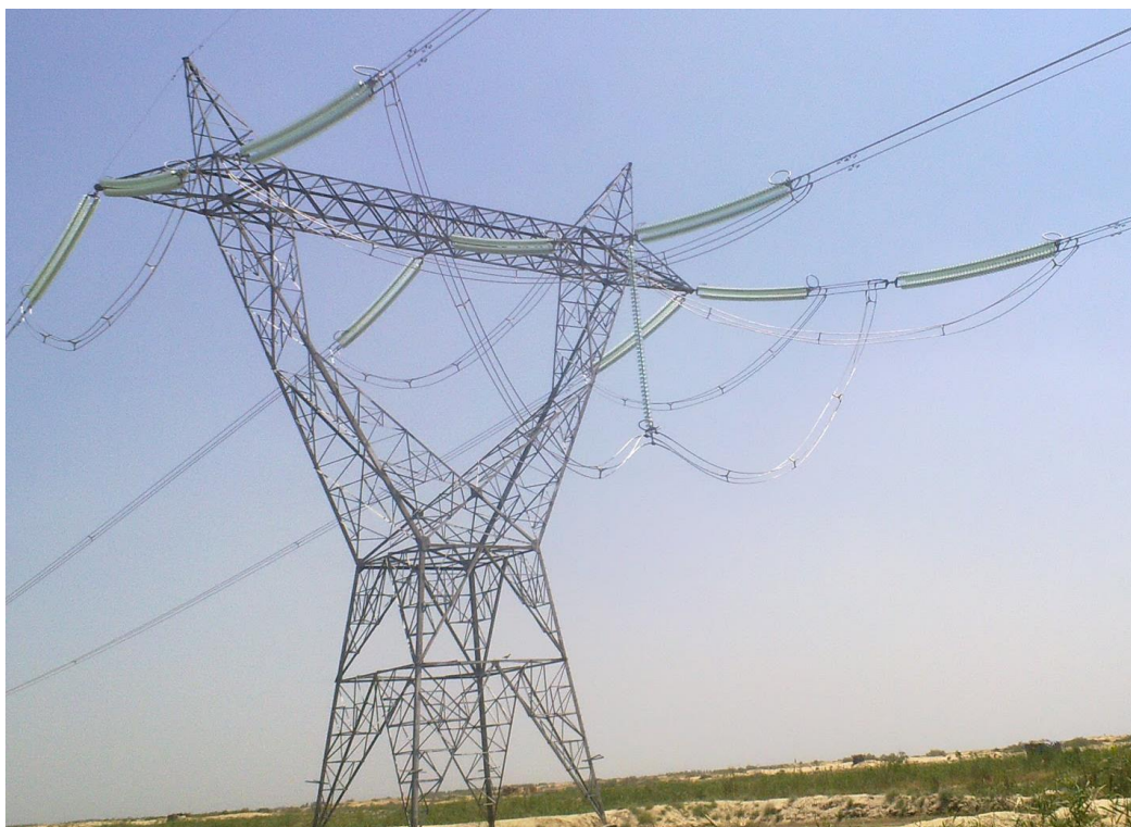
Obr. A.17: Zákrtový stožár typu Kočka 1 [14]
