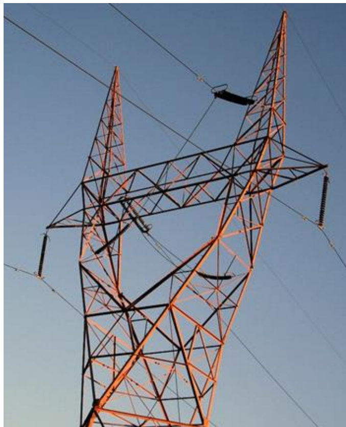
Obr. A.18: Zákrutový stožár typu Kočka 2 [15]
