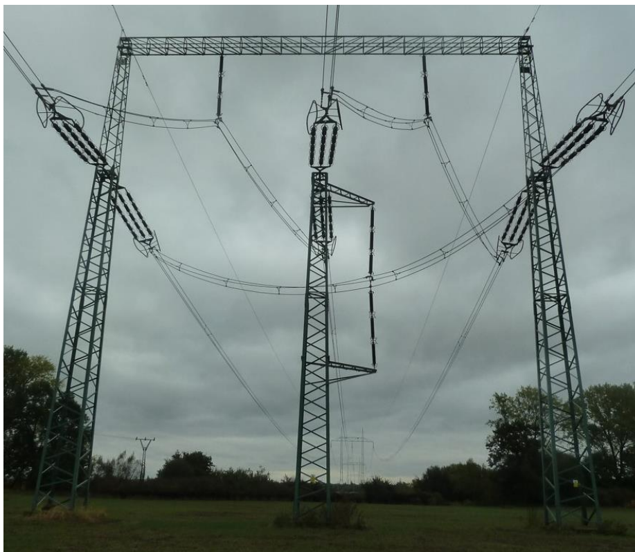
Obr. A.12: Zákrutový stožár typu Třídřík 1 [2]
