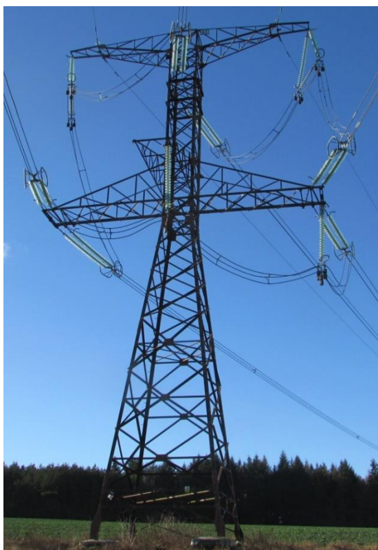
Obr. A.10: Zákrutový stožár typu Delta 1 [2]
