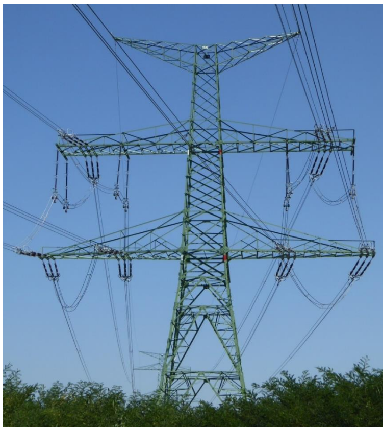
Obr. A.1: Zákrutový stožár typu Dunaj 1 [2]
