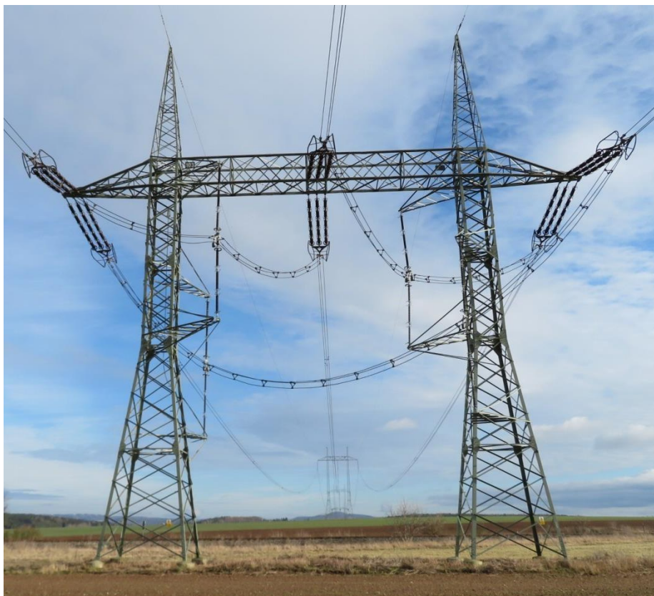
Obr. A.6: Zákřutový stožár typu Portál 1 [2]
