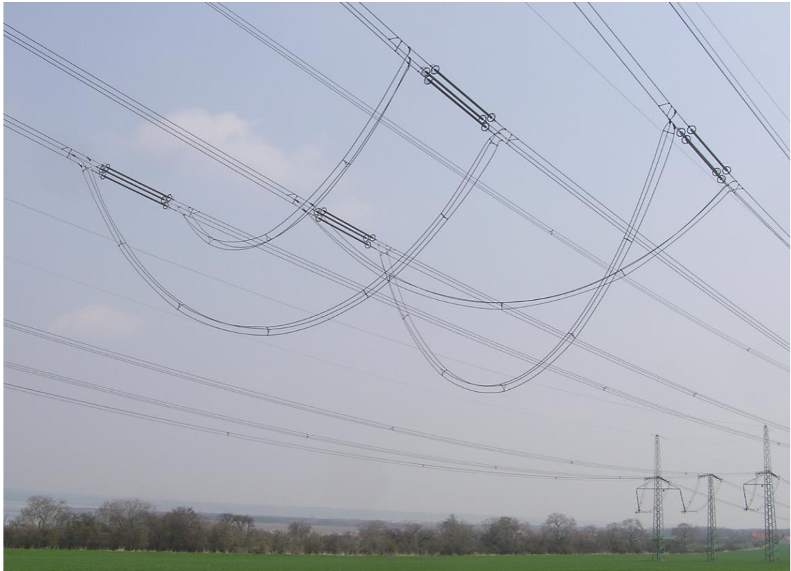
Obr. A.14: Transpozice v rozpětí mezi stožáry 1 [2]
