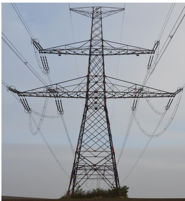
Obr. A.5: Zákrutový stožár typu Dunaj 5 [2]
