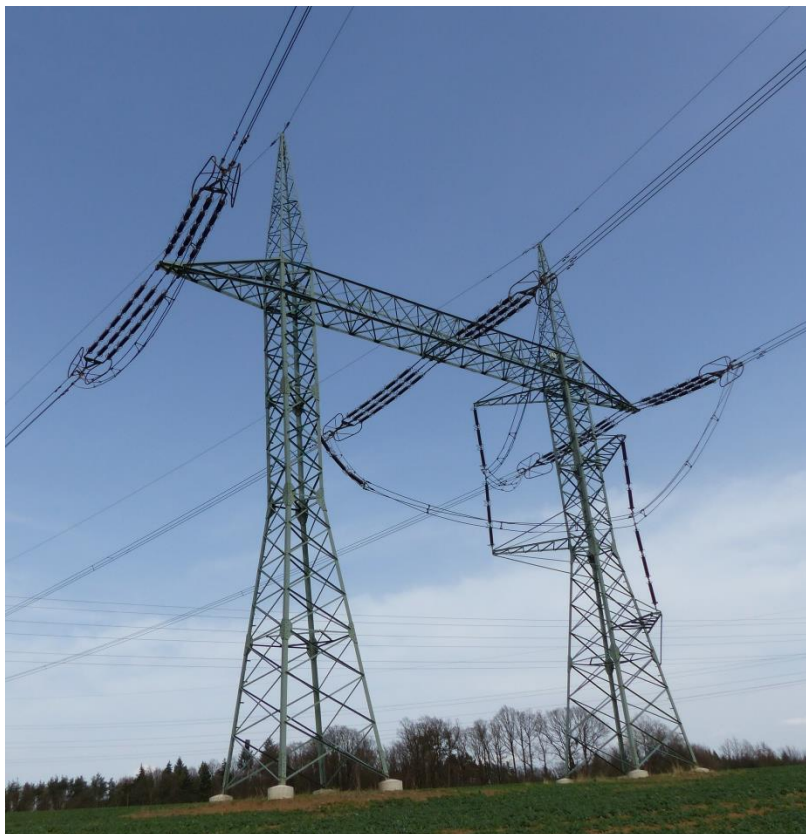
Obr. A.8: Zákrutový stožár typu Portál 3 [2]
