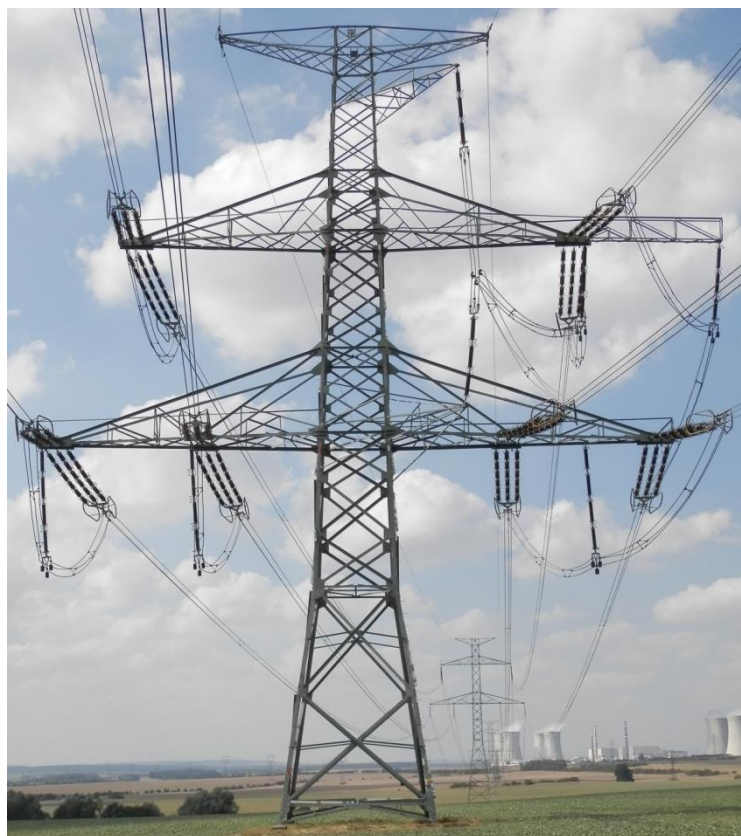
Obr. A.4: Zákrutový stožár typu Dunaj 4 [2]
