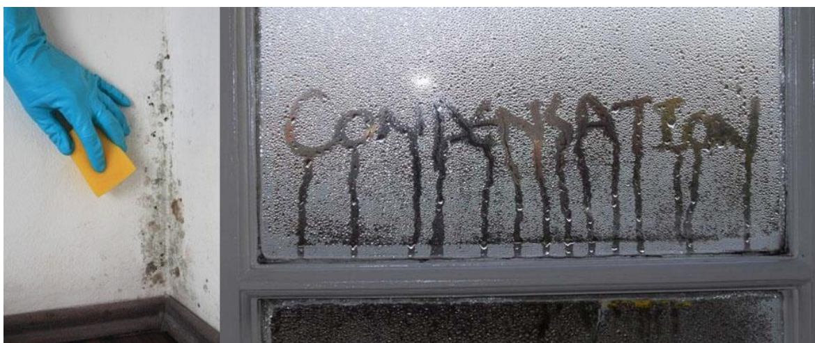
Obrázek 13: Projevy kondenzace vodní páry – plíseň a orosené sklo [25]
