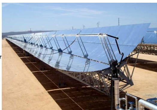
Obrázek 7 – Průběžný parabolický koncentrátor s absorpční trubicí [12]
