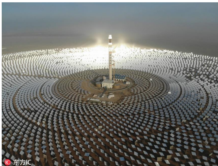
Obrázek 12 – Letecký pohled na sluneční věž s heliostaty v Dunhuangu, Čína [18]
