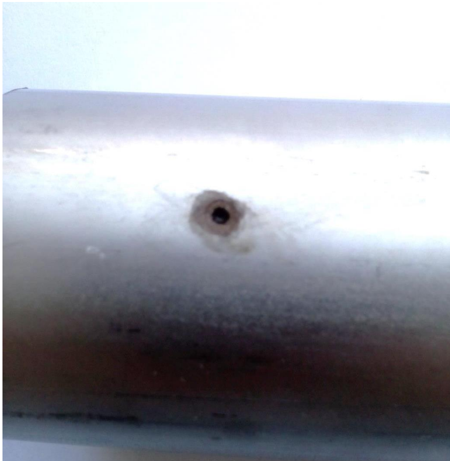
Obr. 20 Korozní napadení trubky pro pivovarské zařízení z oceli AISI 316L
