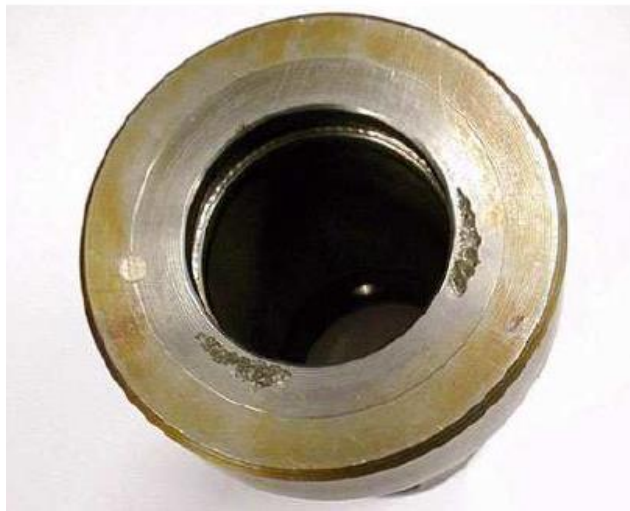
Obr. 5 Štěrbínová koroze oceli vzniklá pod těsněním [17]
