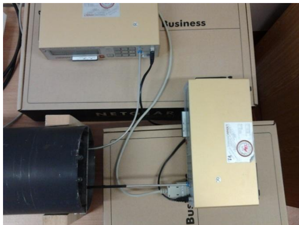
Obr. P1.4: Měření vlivu odběrové trasy – 30 cm rameno
