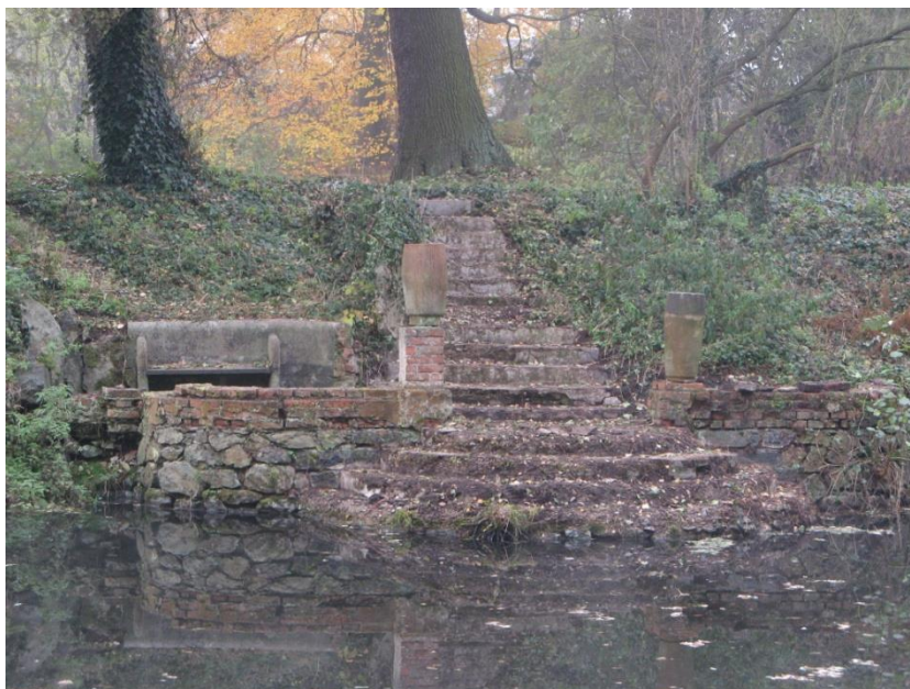
Obrázek 21 – schodiště nad dolním rybníkem před opravou, zdroj: SVSMP
