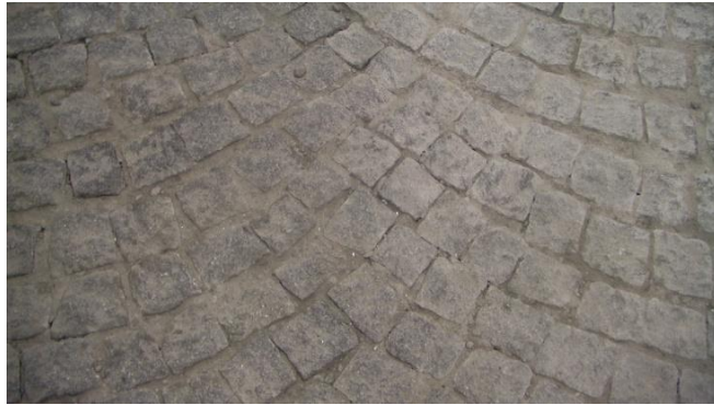
Obr. 23 – Ukázka povrchu – dlažba
