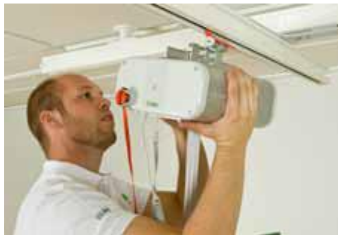
Obrázek 7 - přesun motoru zvedáku dle potřeby [7]
