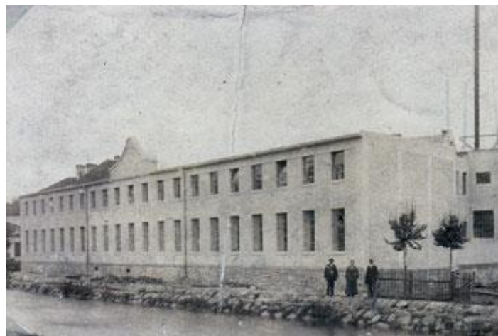
Obr. 6-2: Historický snímek budovy továrny z pohledu od řeky[9]
