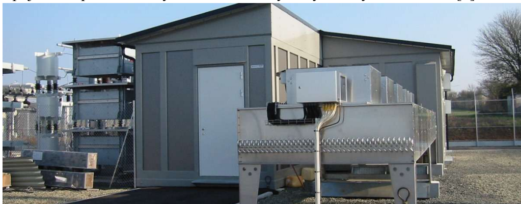
Obr. 3.9: SVC Light jako součást TNS Evron, převzato z [5]
