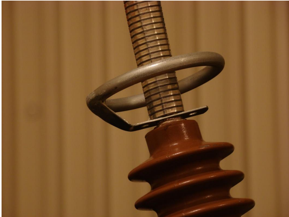
Obr. 22: Ochrana při měření částečných výbojů v transformátoru
