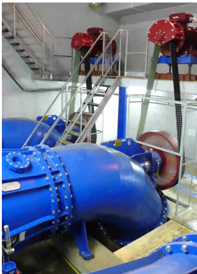
Obr. 4 Fotografie řemenového převodu na generátor (Zdroj: http://www.hydrohrom.cz )
