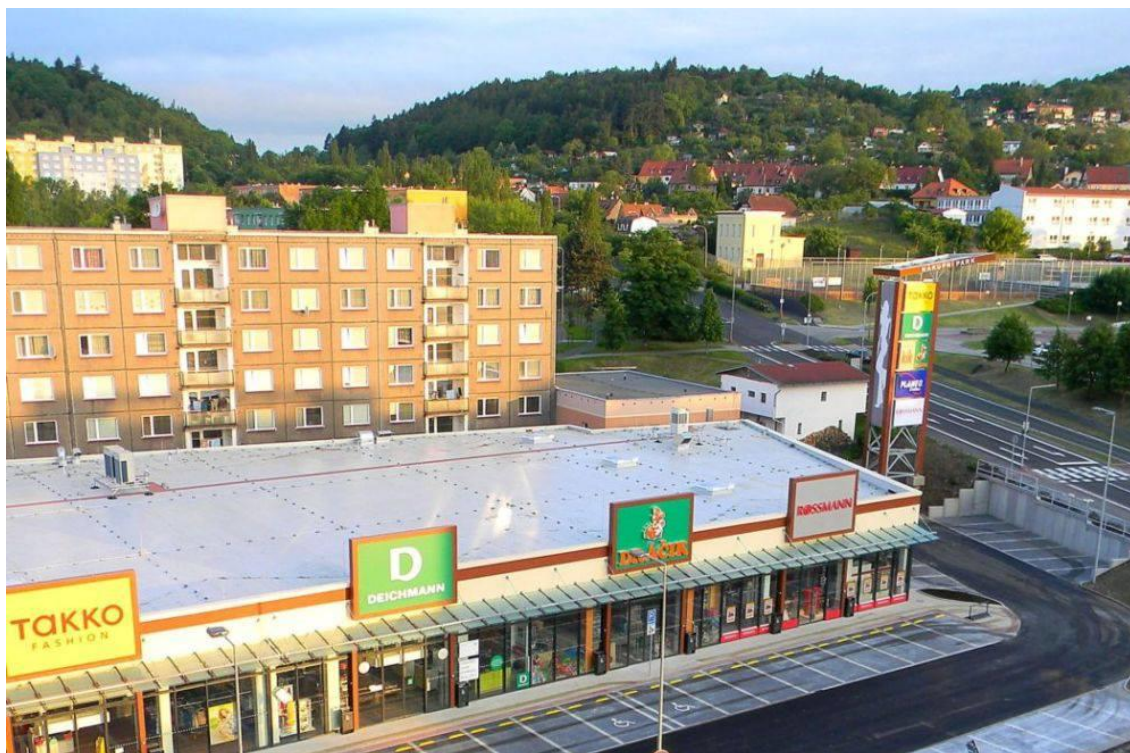
Obrázek 10 Pohled na hotové OC Kadaň
