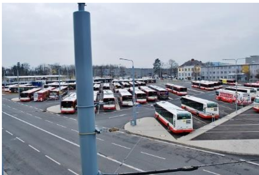
Obrázek 9 Plzeňské depo MHD. Zdroj: Třetím rokem je v provozu nejmodernější evropské depo MHD v Plzni. Dostupné z: http://www.buspress.eu/tretim-rokem-je-v-provozu-nejmodernejsi-evropske-depo-mhd-v-plzni/
