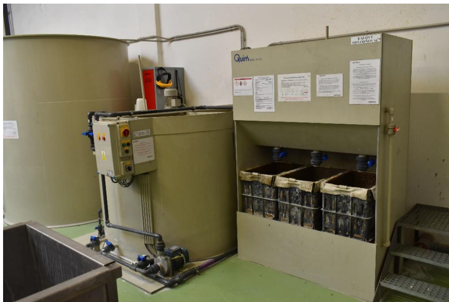
Obrázek 3-7: Kalový odvodňovač.
