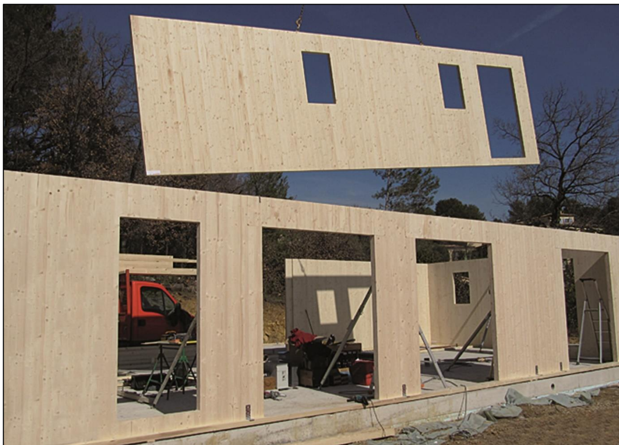
Obrázek č. 45 – Ukázka montáže dřevěného masivního panelu na stavbě, zdroj: [30]
