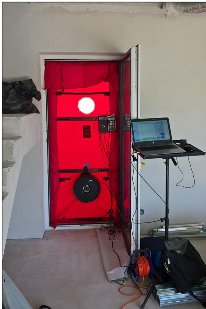
Obrázek č. 2 – Ukázka osazení ventilátoru do vchodových dveří při měření blower door testu, zdroj: [12]
