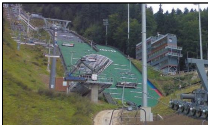
Obr. č. 68: Příklad součástí v lyžařském středisku chráněné zinkovým povlakem vytvořeném žárovým zinkováním ponorem [74]
