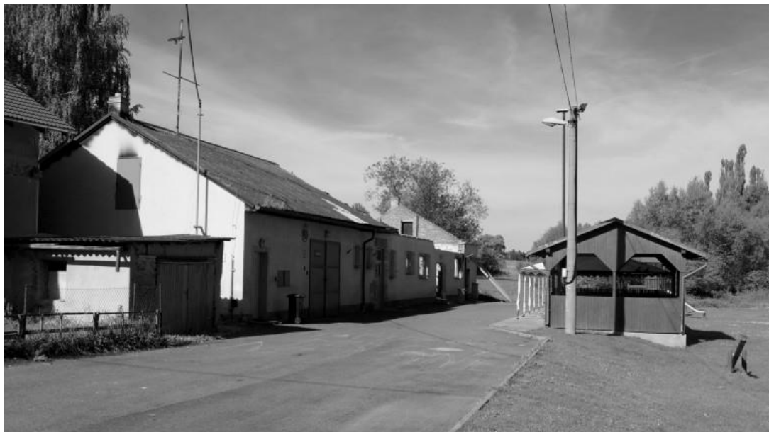
Obrázek 11 – Budova Hostince u Mecha po požáru 111
