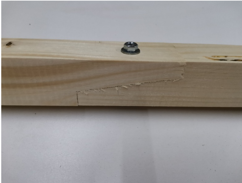
Obr. 20 – podélný spoj se svorníkem [17]
