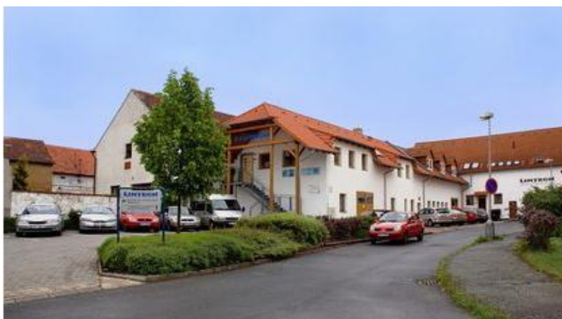
Obrázek č. 2: Budova firmy LINTECH, spol. s r. o. v Chrastavicích
