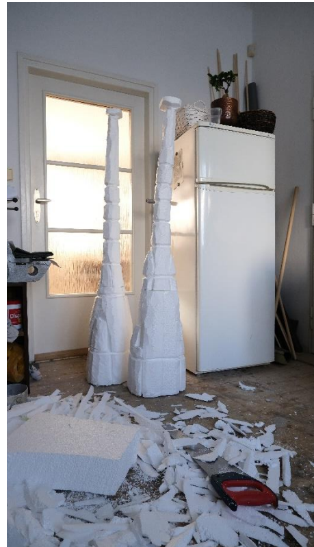
Obrázek 10: práce na objektech
