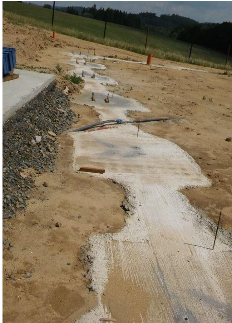
Obrázek 47: Základy výrobní haly
