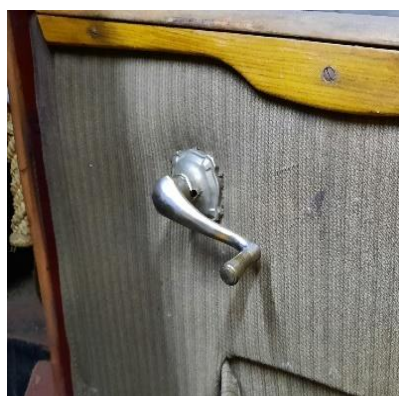
Obr. 26: Původní klička s podložkou
