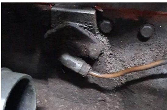
Obr. 28: Upravené vyústění pro tlakoměr
