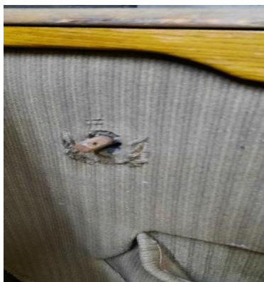
Obr. 25: Chybějící klička
