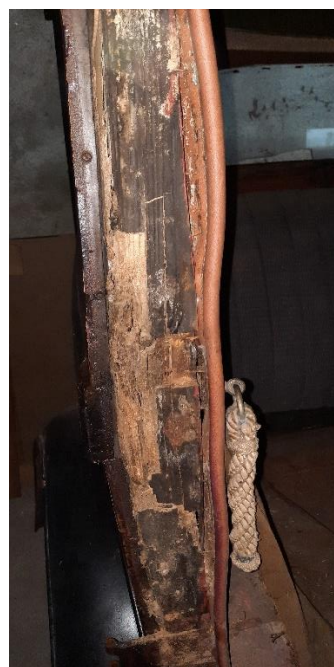
Obr. 34: Sloupek po demontáži dveří
