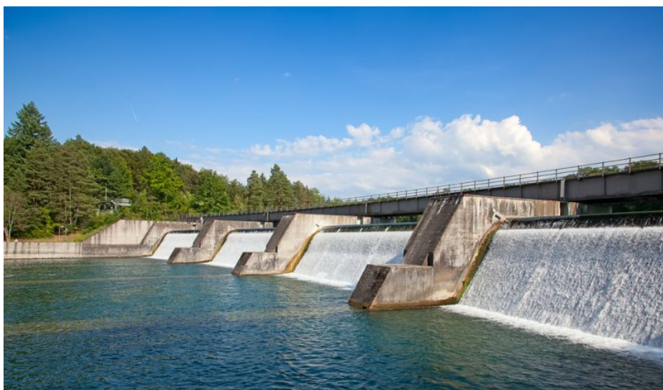
Obrázek 2.17: Průtočná vodní elektrárna na řece Rýn v Německu [27]
