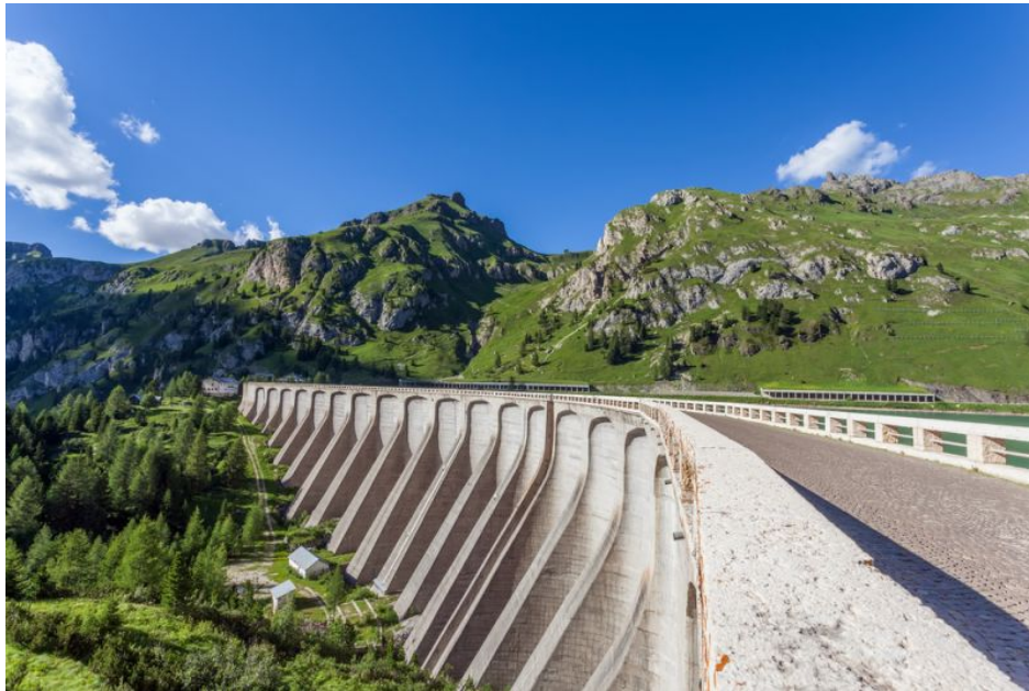
Obrázek 2.15: Hráz s opěrnými pilíři poblíž italských Dolomit [23]
