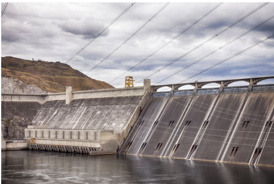
Obrázek 2.14: Gravitační hráz přehrady Grand Coulee v USA [23]
