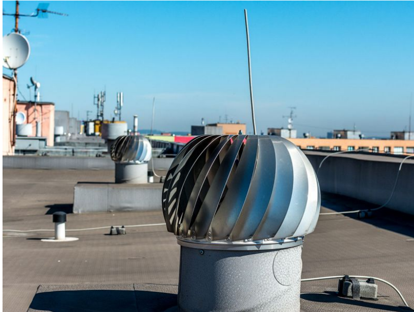
Obrázek 2.8: Střešní Savionova turbína [28]
