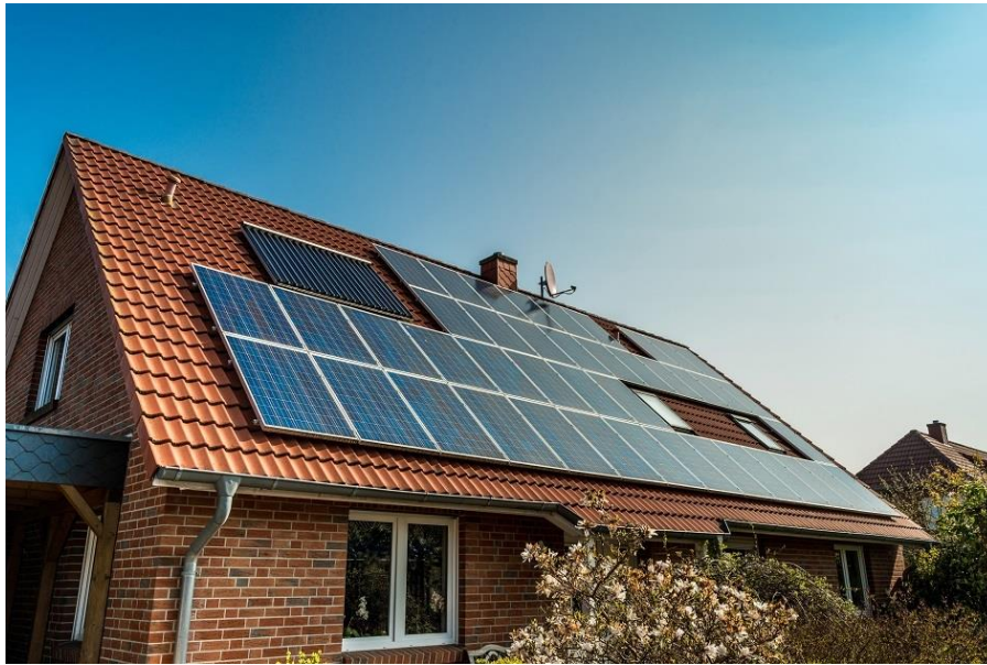
Obr. 4: Fotovoltaické panely + solární kolektor umístěné na střeše rodinného domu. [10]
