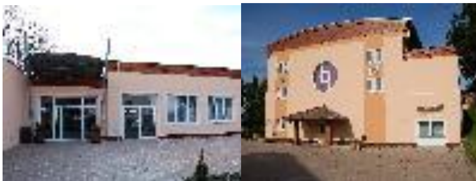
Obrázek: multifunkční centrum po rekonstrukci
