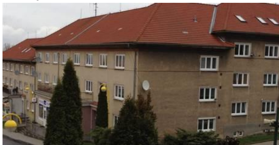
Obrázek: zateplení náměstí východní strana – před rekonstrukcí
