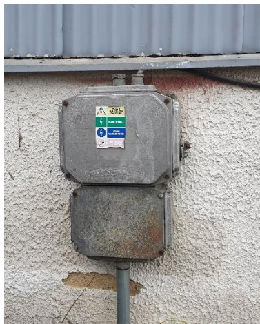
Obr. 1.28 – Litinový podružný rozváděč u obloukové haly
