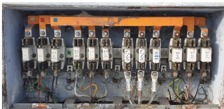
Obr. 1.9 – Rozpojovací jisticí skříň
