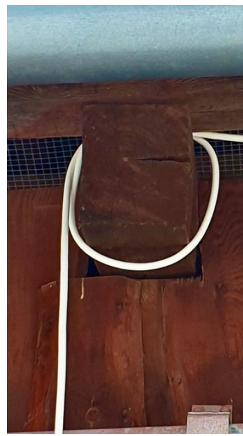
Obr. 1.16 – Prodlužovací kabel omotaný kolem krokví
