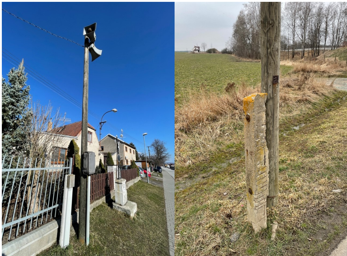
Obr. 2.6 - Dřevěný sloup zasazený přímo do země a na betonové patce, [Zdroj: Archiv autora]
