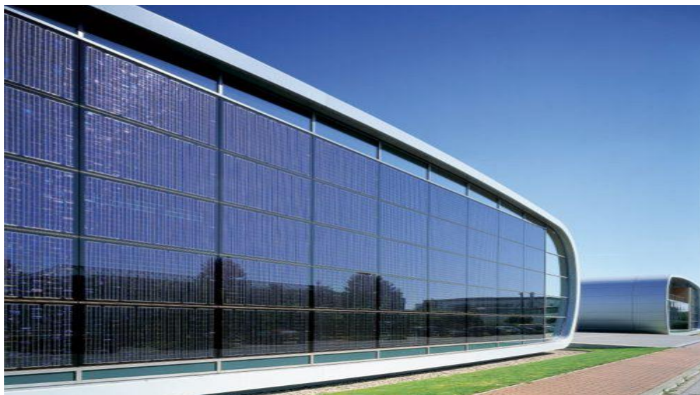
Obr. 1.15 FV panely nainstalované na fasádu [28]
