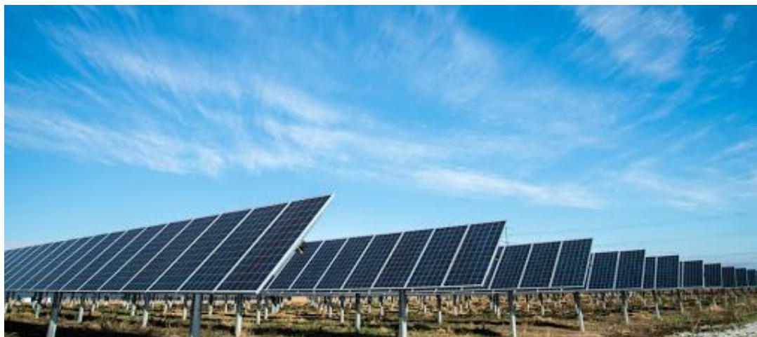
Obr. 1.16 FV panely nainstalované na volném prostranství [29]
