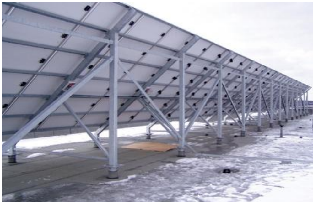
Obr. 1.18 Konstrukce analyzované elektrárny [31]
