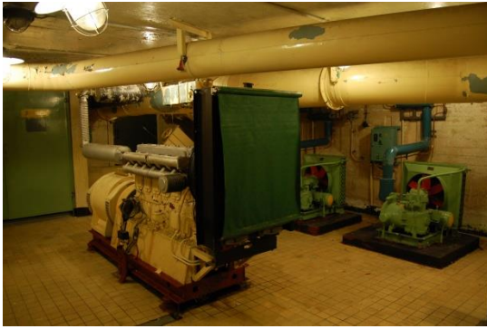
Дизель-генераторная комната и сам двигатель производства «Шкода»
