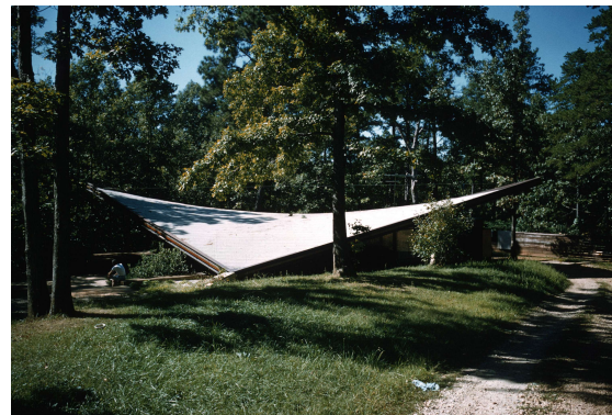
(b) Střechu svého domu v Raleigh si architekt Eduardo Catalano navrhl ve tvaru hyperbolického paraboloidu. Zdroj: [73].
