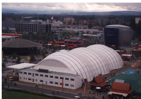
(a) Japonský pavilon na světové výstavě Expo 2000 měl nosnou konstrukci ve tvaru translační plochy. Zdroj: [68].
