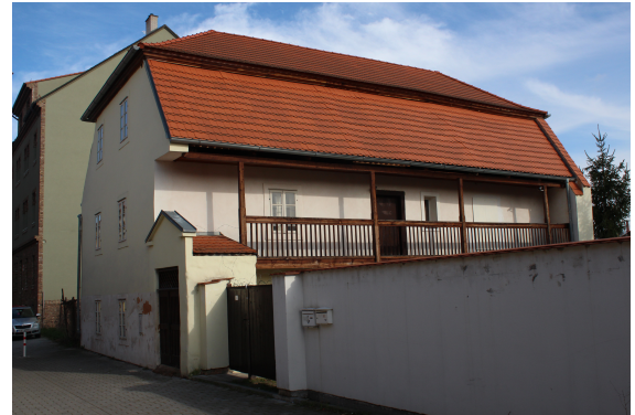
(d) pohled z ulice, zdroj: vlastní
