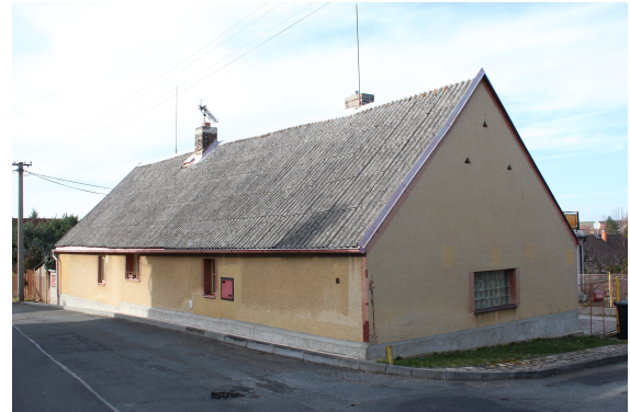
(d) pohled z ulice, zdroj: vlastní
