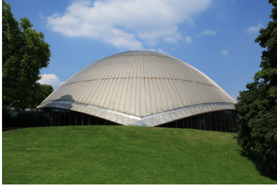
(a) Obvodový plášť Zeissova planetária v Bochumi v Německu je tvořen částí rotačního paraboloidu. Zdroj: [66].
