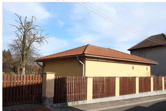
(d) pohled z ulice, zdroj: vlastní
