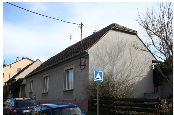
(d) pohled z ulice, zdroj: vlastní
