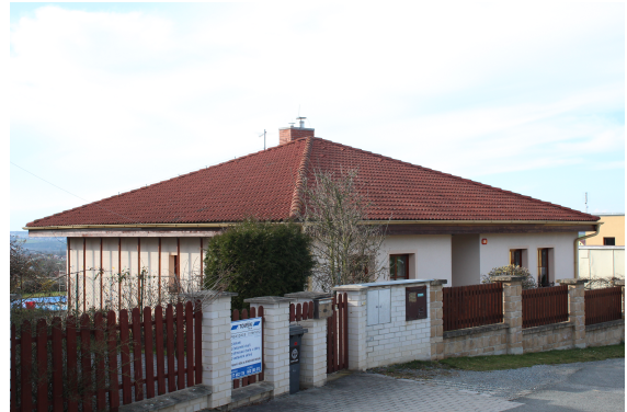
(d) pohled z ulice, zdroj: vlastní
