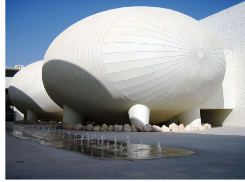
(b) Budovy Cornellovy univerzity v Kataru jsou ve tvaru protáhlého elipsoidu. Zdroj: [67].
