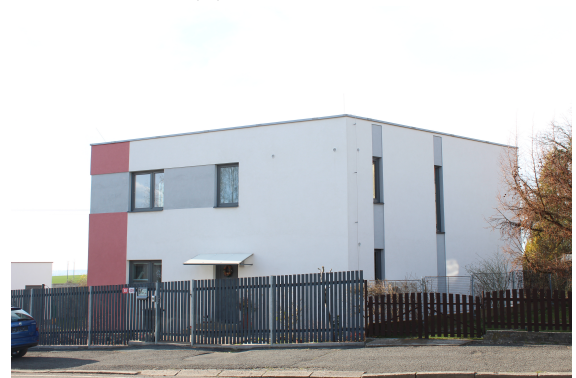
(d) pohled z ulice, zdroj: vlastní
