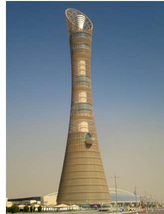
(b) Hotel Aspire Tower v Kataru byl postaven ve tvaru jednodílného rotačního hyperboloidu. Zdroj: [63].
