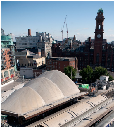
(a) Železniční stanice Manchester Oxford Road v Anglii byla postavena ve tvaru tří konoidů. Zdroj: [72].
