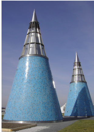
(a) Obvodové pláště galerie Bundeskunsthalle v Německu jsou ve tvaru rotační kuželové plochy. Zdroj: [62].
