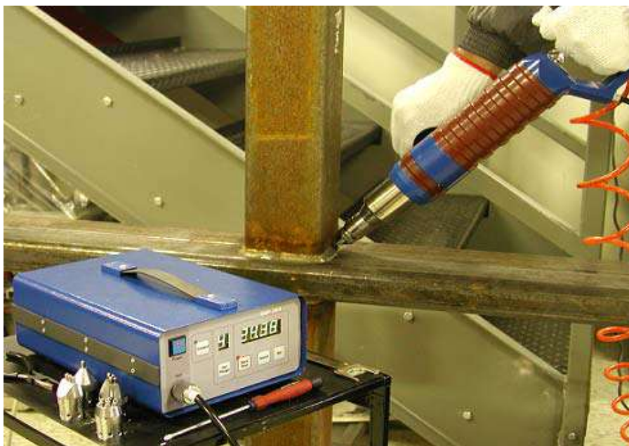
Obr. 4.2-2 Ruční UP modifikace svarových spojů [8]
