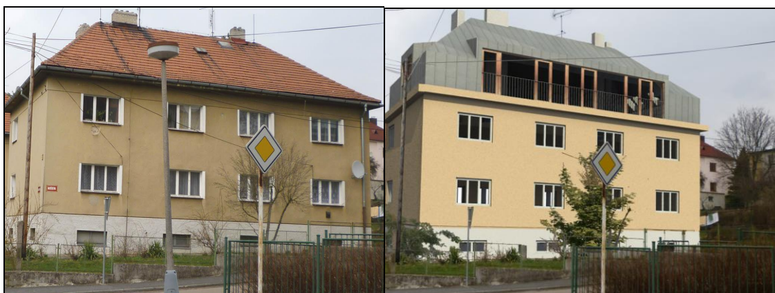
Obr. 2.5 Bytový objekt před návrhem a po návrhu
