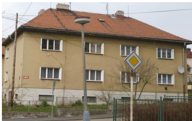
Obr. 1.1 Bytový objekt zezadu
